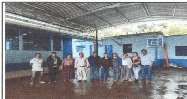
Foto 5: finalización del entechado
