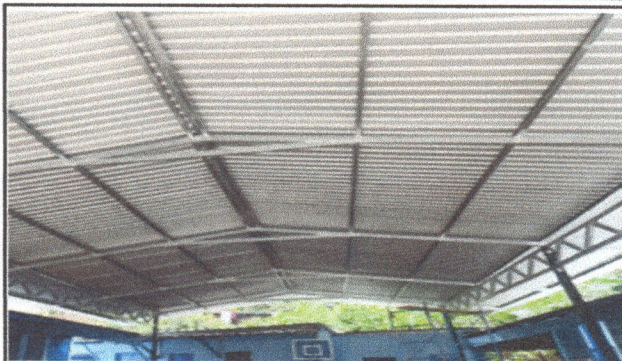
Foto 2: Instalacion de yois .
